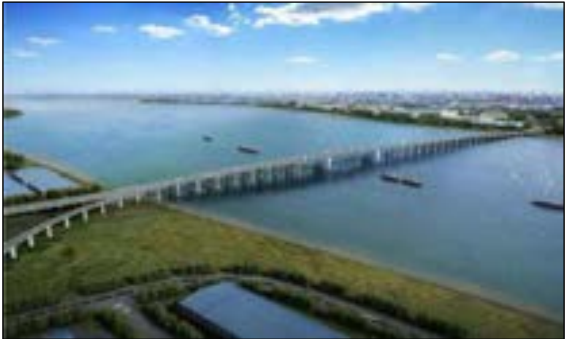
图 4.10-1 桥梁整体鸟瞰视角
