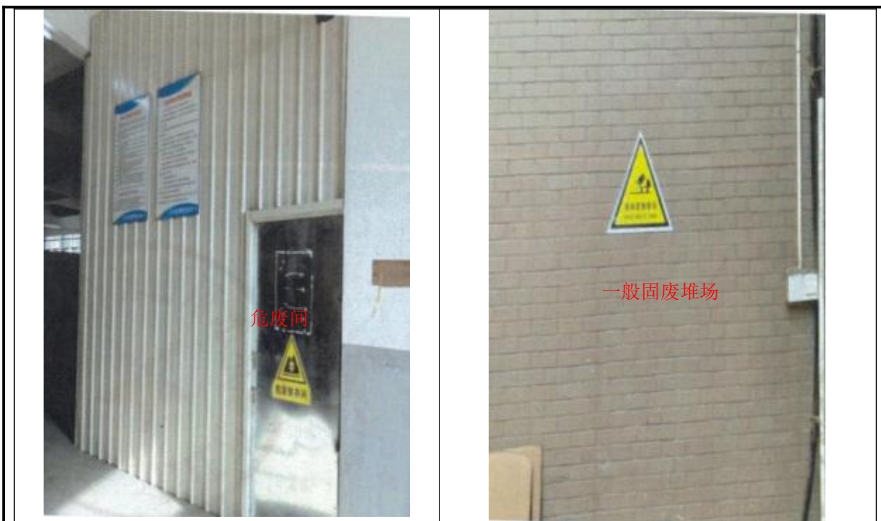
图 3-3 项目固废暂存处图片
