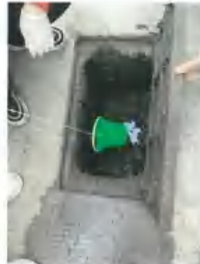
生活污水排放口 W1
