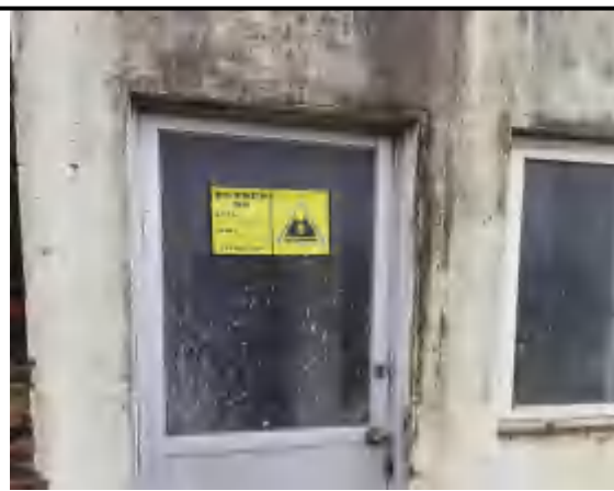
危废暂存间外部
