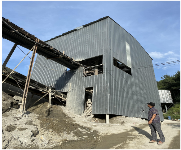
图 2 破碎车间钢结构密闭
