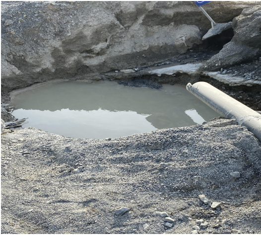
图 1 雨污水沉淀池
