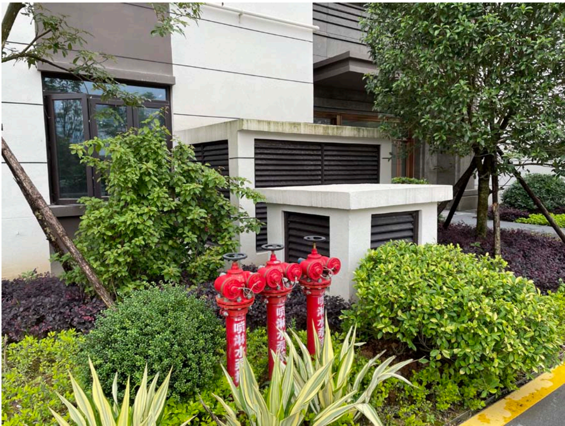
柴油发电机房排风口
