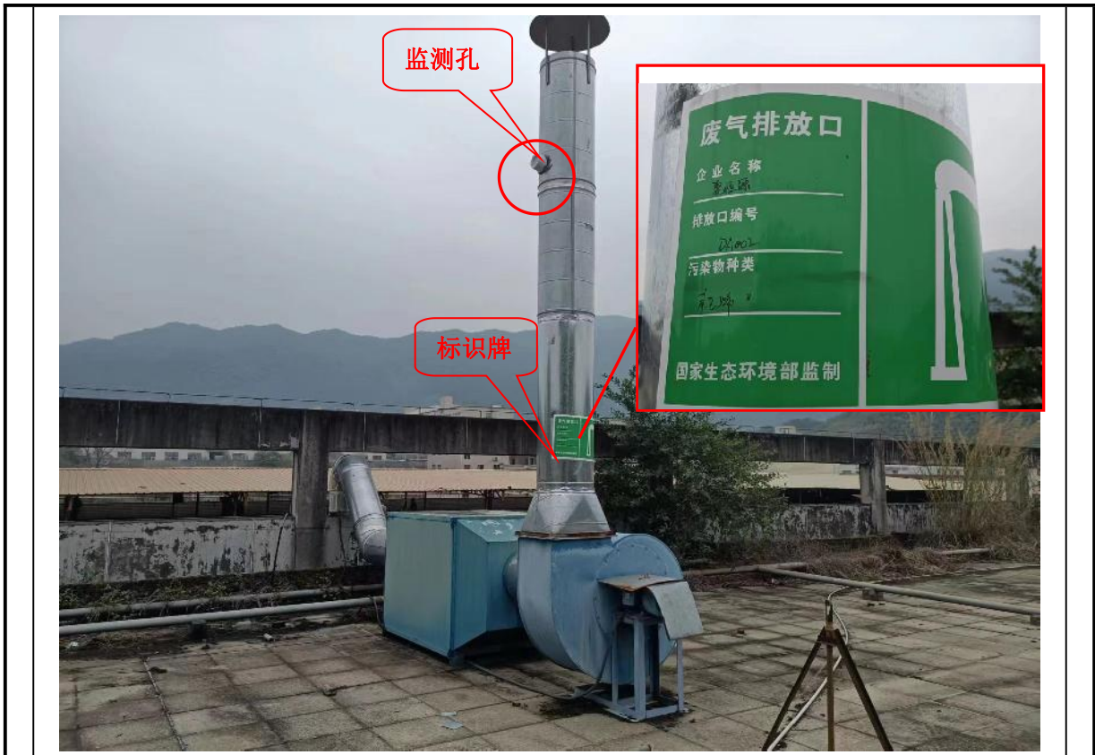
图片 2 DA002 监测孔及标识牌
