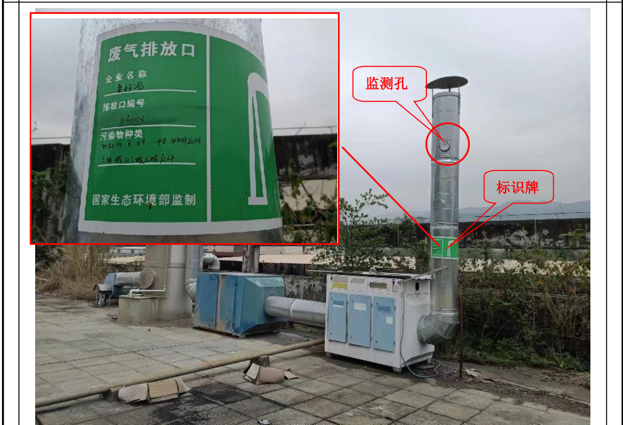
图片 3 DA003 监测孔及标识牌
