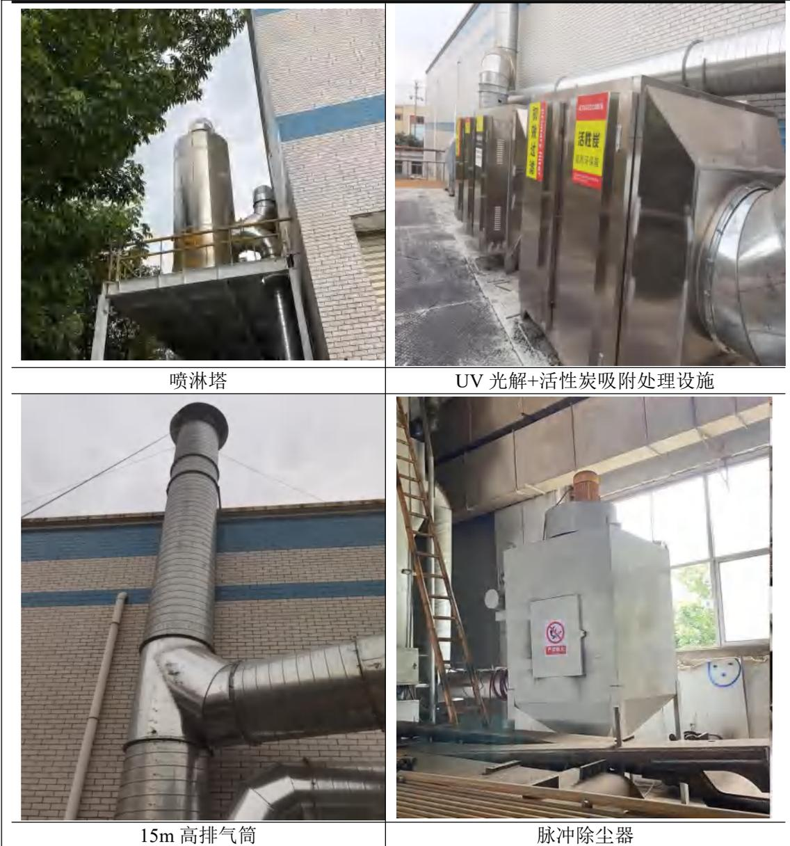
图3.2-3 相关废气处理设施照片
