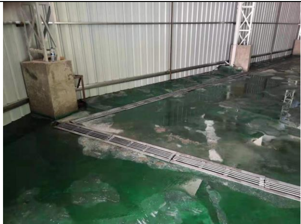
废渣暂存间地面导流沟
