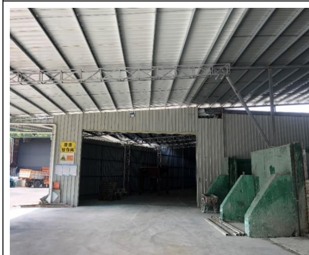
废渣暂存间外部
