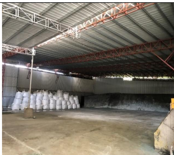
废渣暂存间内部
