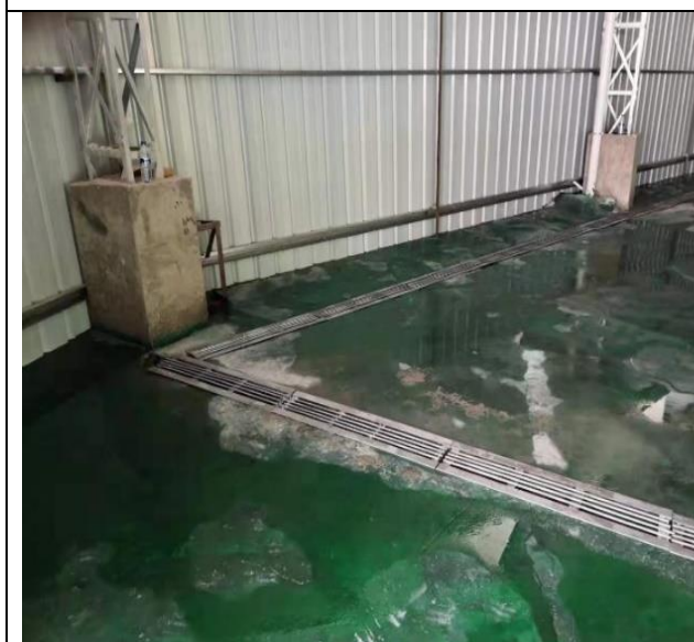
废渣暂存间收集沟
