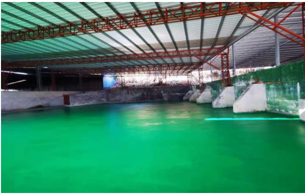
废渣暂存间地面防渗
