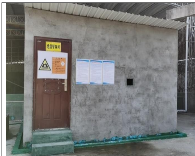
危废贮存间外部
