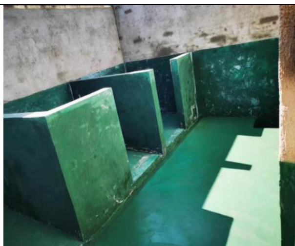
危废贮存间内部
