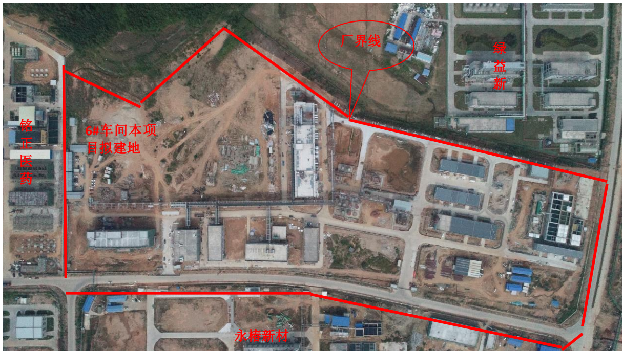
全厂现状面貌
