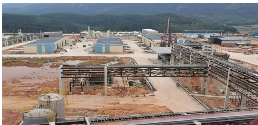
厂区现有仓库及污水处理站现状图
