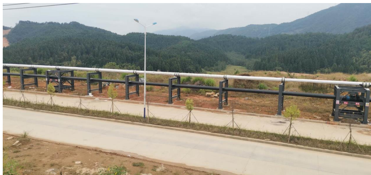
厂区东侧园区道路及供热管道
