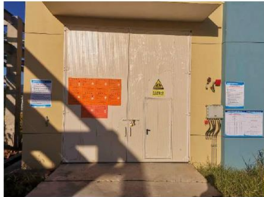
危险废物暂存间
