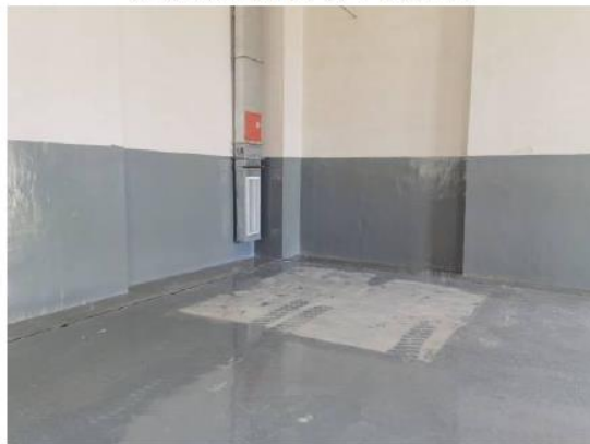
危险废物暂存间防渗
