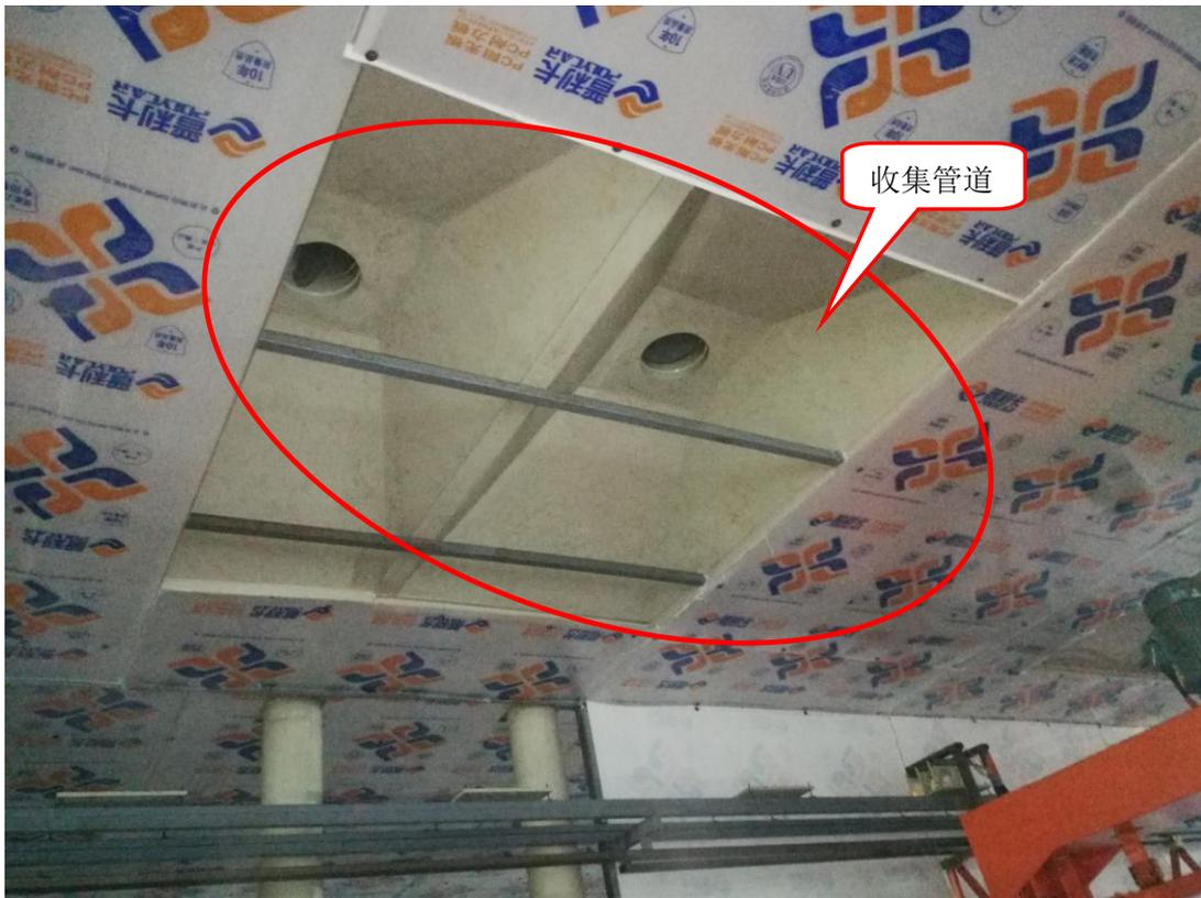
图片 2 酸洗废气收集管道
