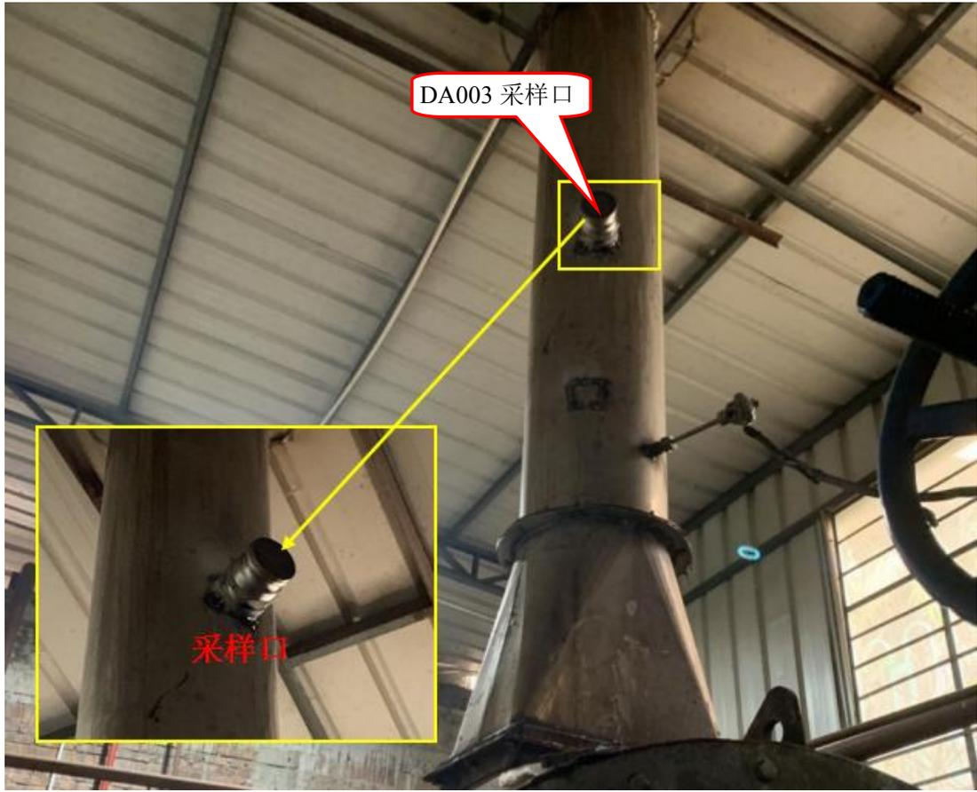
图片 4 锅炉废气采样口
