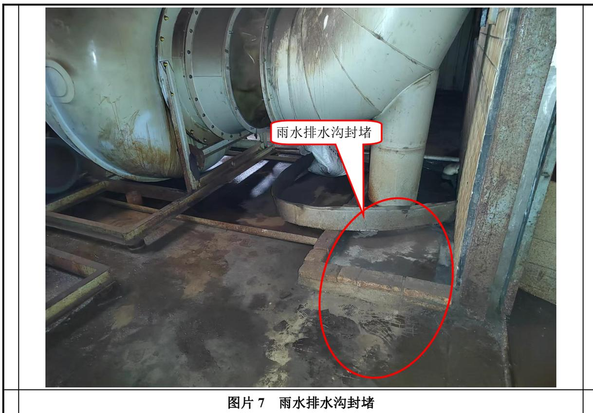
图片 7 雨水排水沟封堵
