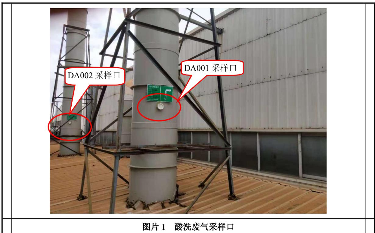
图片 1 酸洗废气采样口
