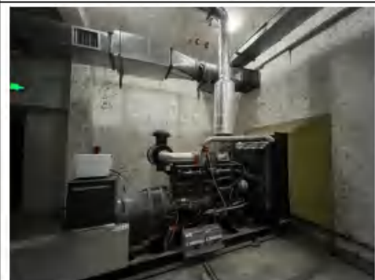
使用吸声减震材料包覆
