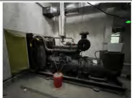
发电机设置减振器
