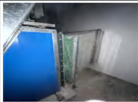
风机进出口设置软接头
