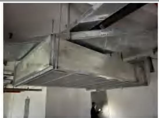
风管吊装设置橡胶隔振垫
