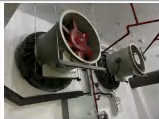
风管吊装设置橡胶隔振垫
