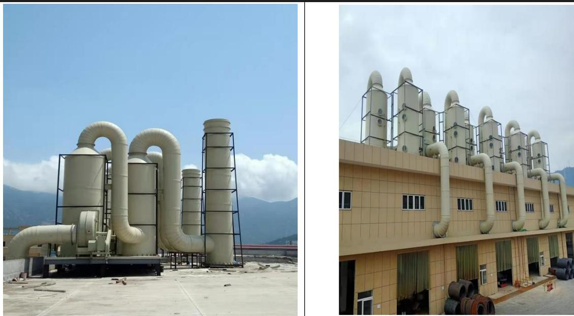
图 3.1-2 酸洗废气处理设施图
