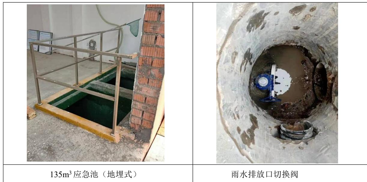
图 3.2-1 事故应急池、雨水排放口切换阀照片
