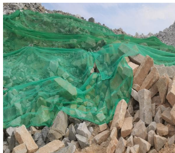
堆场防尘网覆盖
