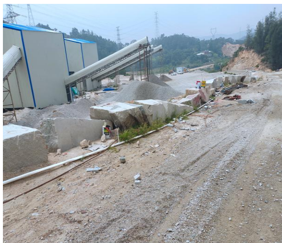
厂界喷淋设施
