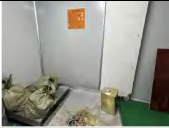
危废暂存间内部
