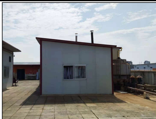
图 3-2 废气排气筒照片
