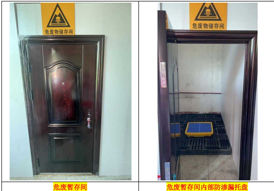
图 4.1-4 固体废物暂存设施照片
