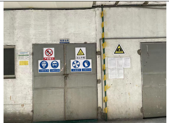
危险废物暂存间局部图
