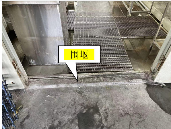
阳极氧化车间围堰
