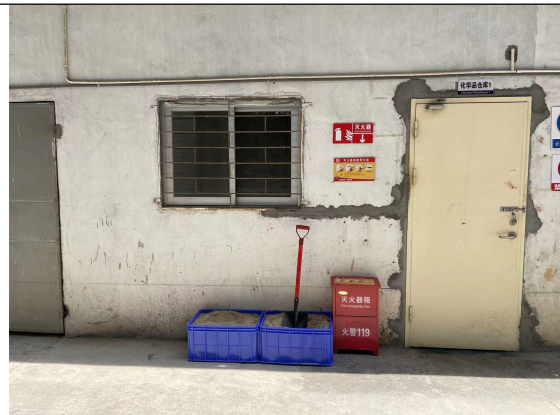
消防沙及灭火器
