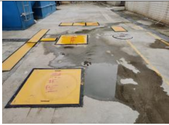
废水处理设施调节池
