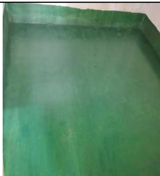
危废暂存间内部
