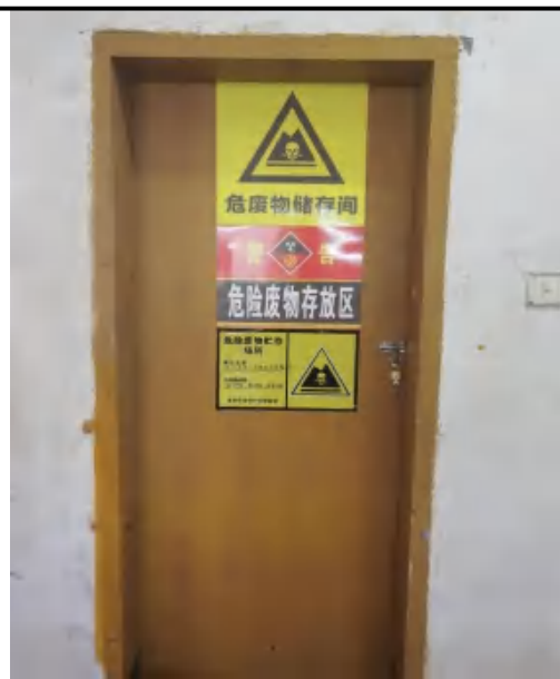
危废暂存间外
