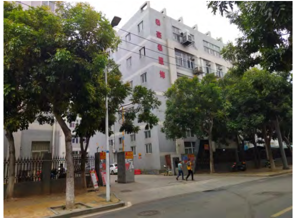
北面泰豪泰服饰、同安一建
