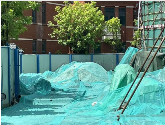
施工弃土覆盖局部图
