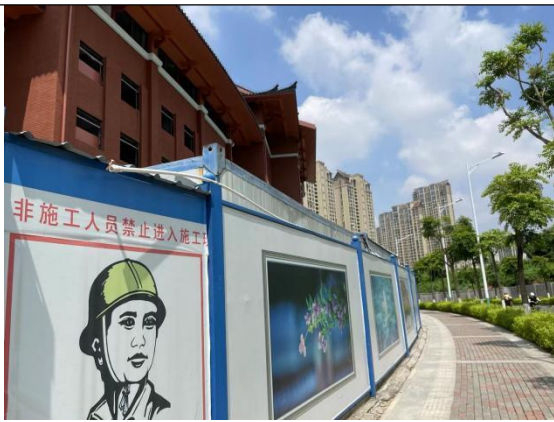
施工现场围挡
