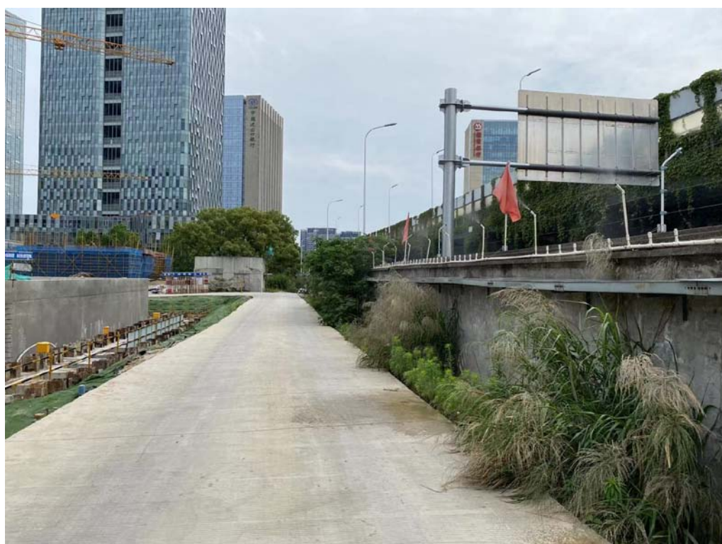
施工厂界喷淋除尘
