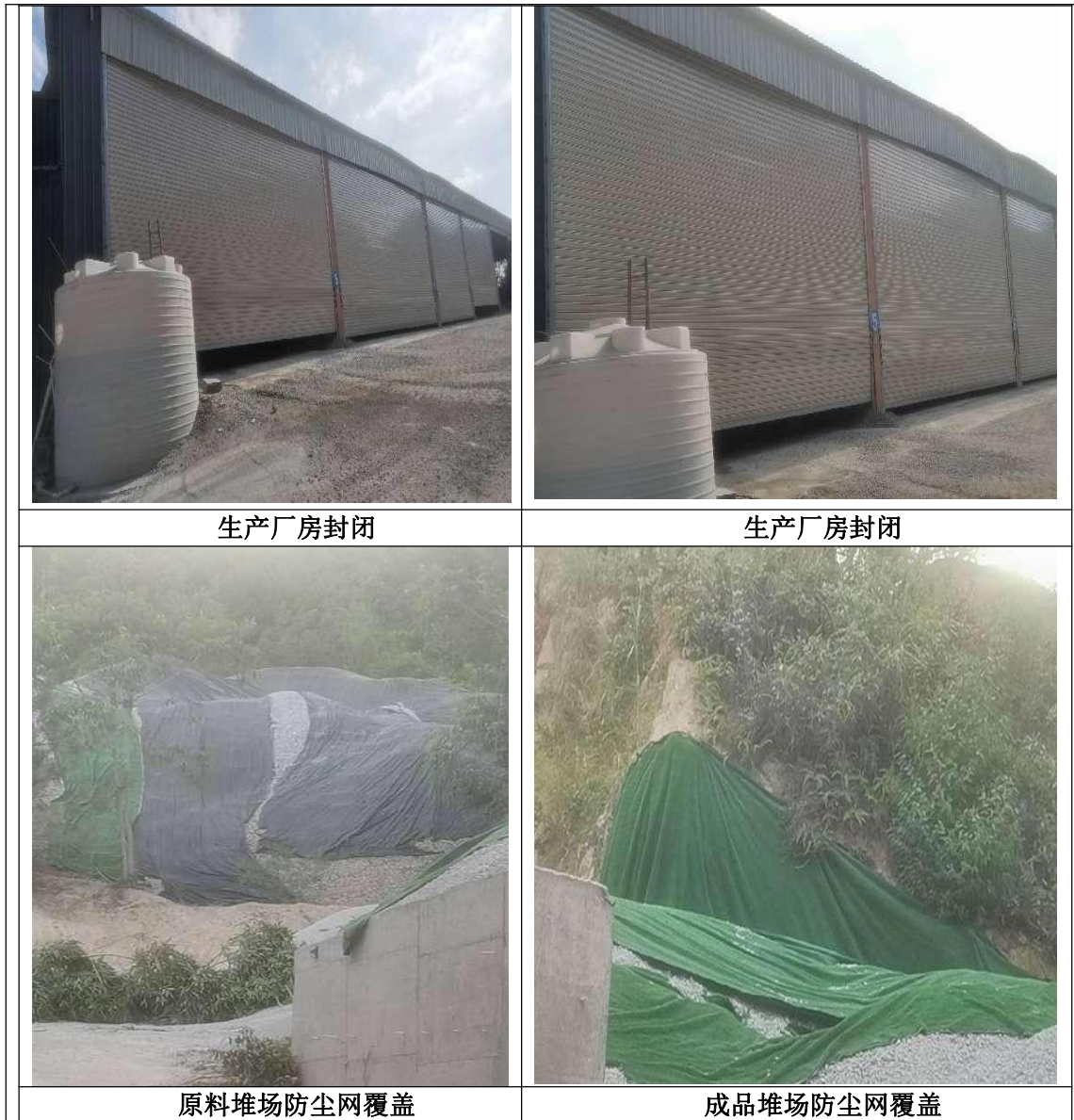
图 3-3 项目废气处理设施现场照片图
