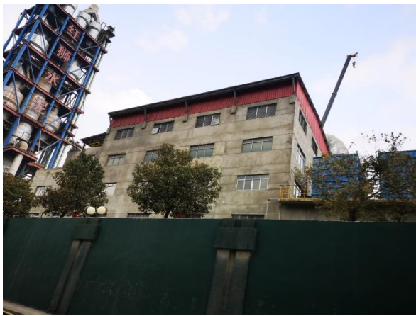
老矿山廊道终点（红狮三期厂区）
