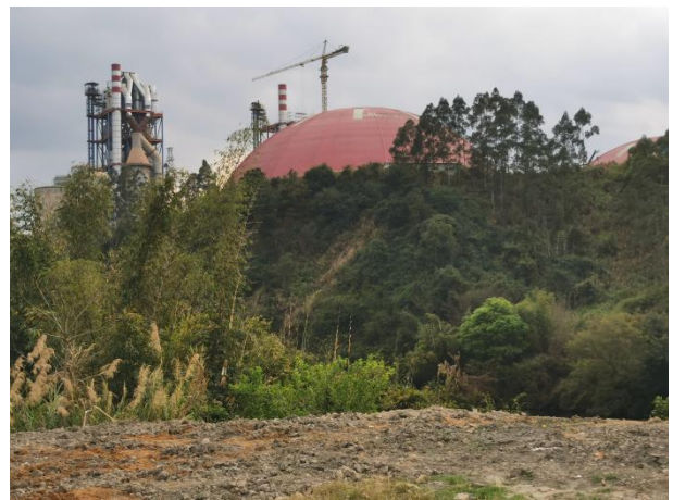
老矿山廊道终点周边（红狮一二期厂区）
