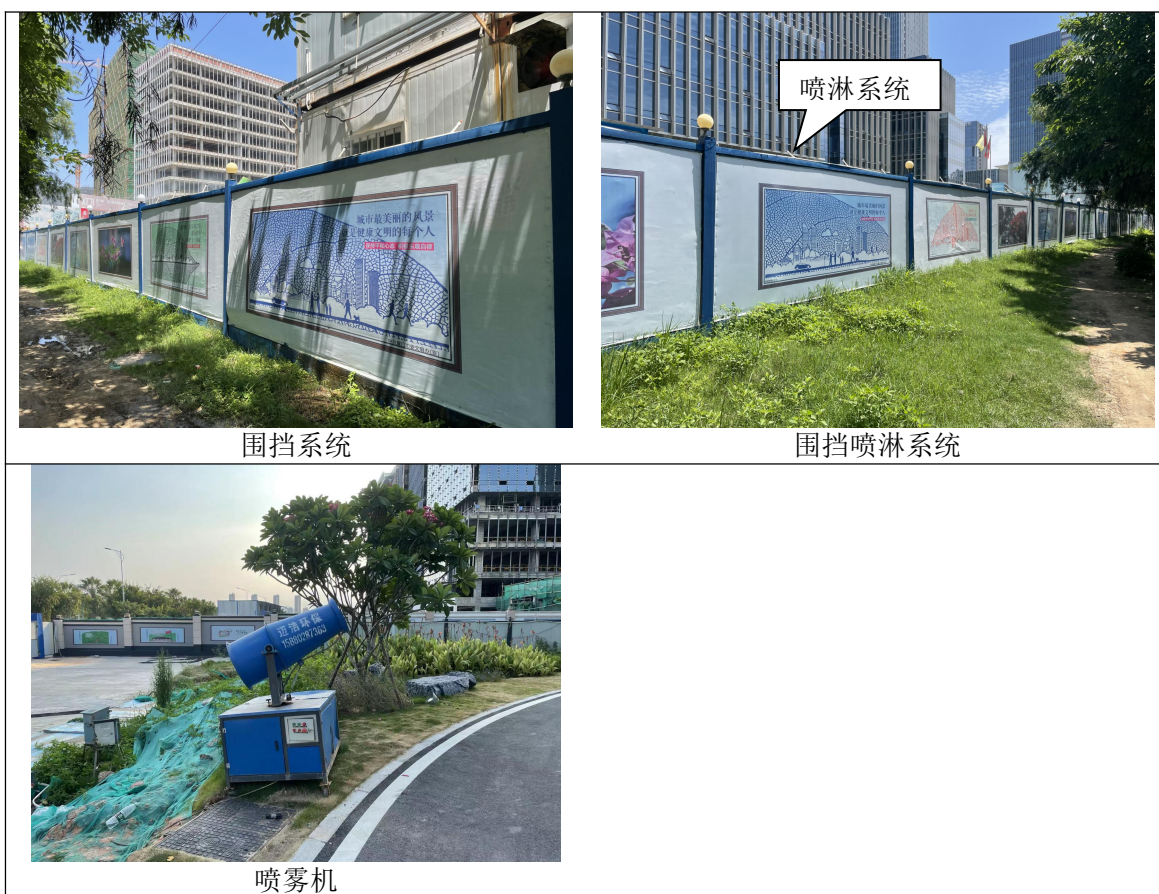
图 4-3 施工期扬尘治理措施局部图
