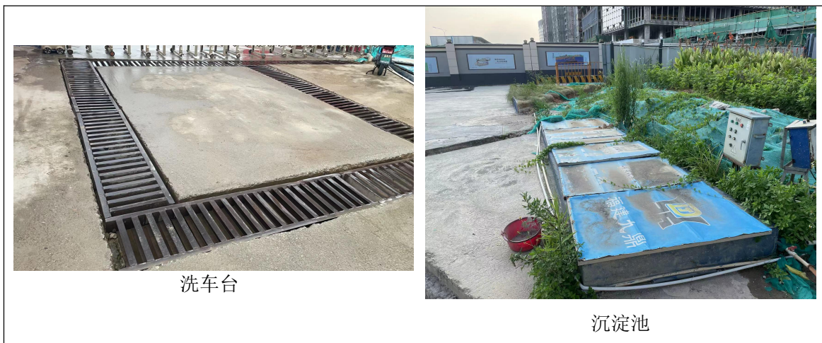
图 4-1 运输车辆设置的清洗设施情况现场图
