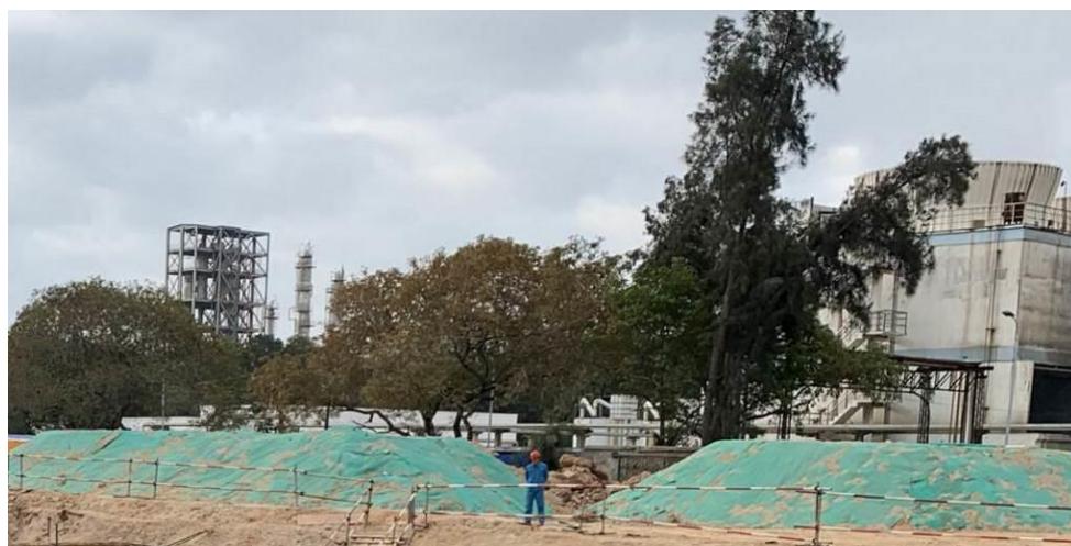
施工现场土方覆盖防扬尘措施
