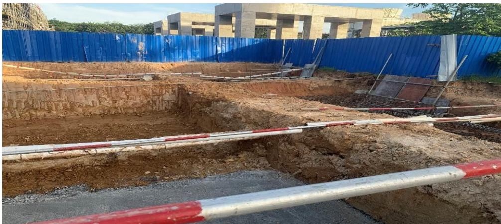
施工现场四周围挡防扬尘措施
