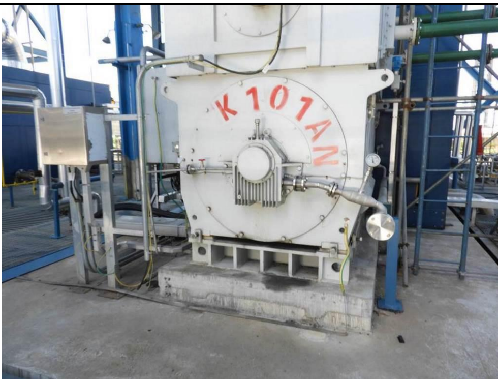
设备基础减震垫
