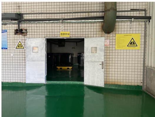
危险废物暂存间
