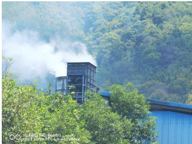
图 3.6-2 炭活化废气排气筒
