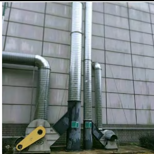
喷粉废气排放口
