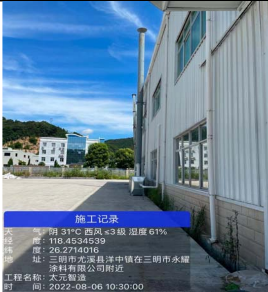
挤出废气治理设施及排气筒
