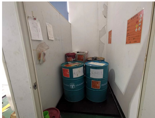
图 3-4 危废暂存间防渗、防泄漏措施
