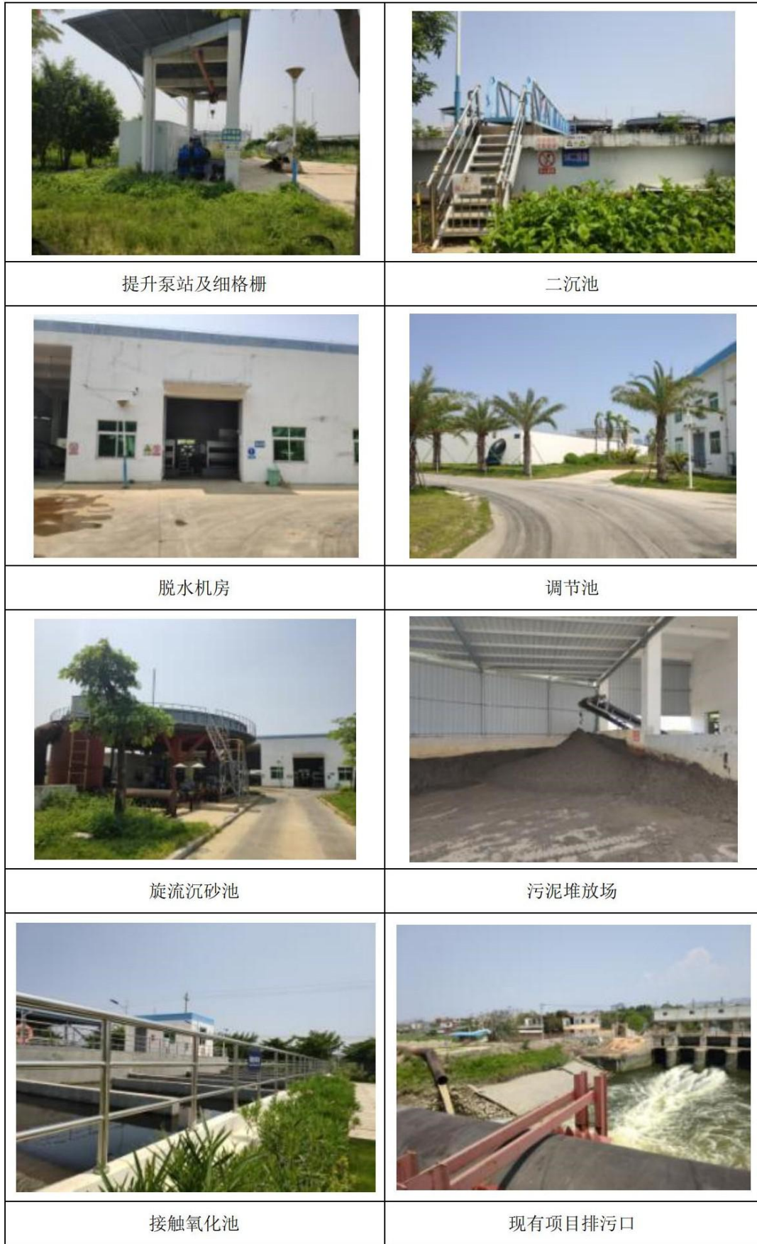
图 3.1-2 角美城市污水处理厂现有工程现状照片
