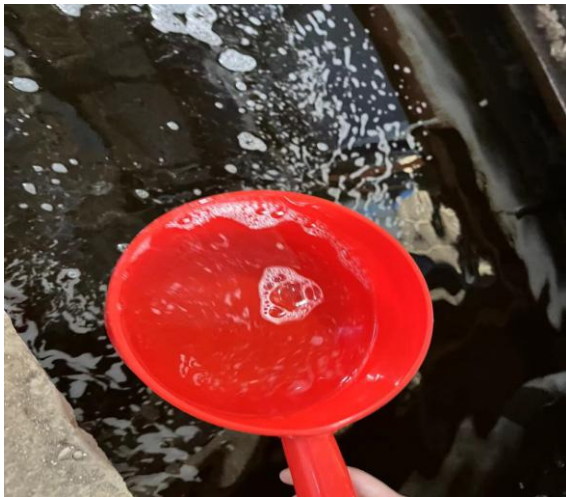
废水设施出口
