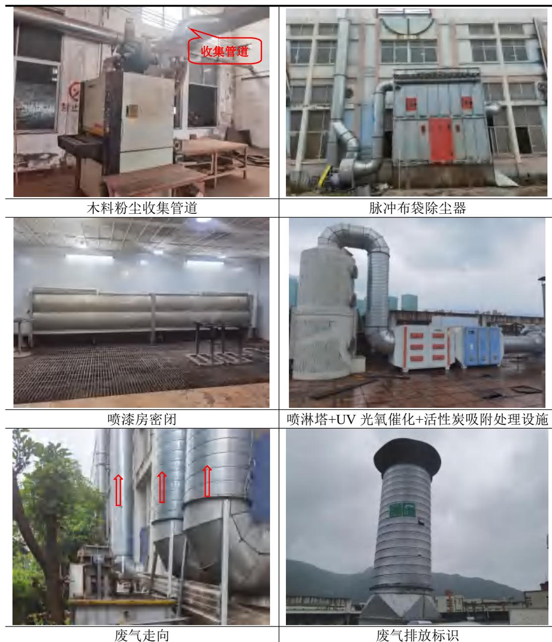
图3.2-3 相关废气处理设施照片
