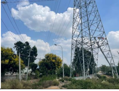
32#塔基植被恢复
