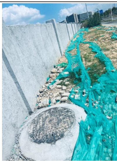
地下电缆植被恢复
