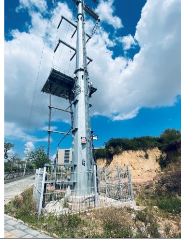
7#塔基植被恢复
