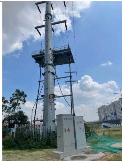
14#塔基植被恢复
