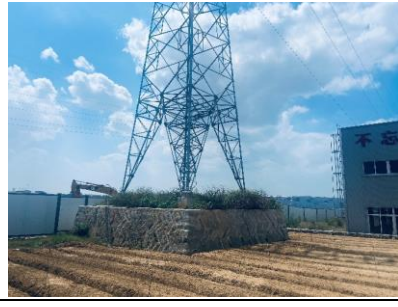
24#塔基植被恢复
