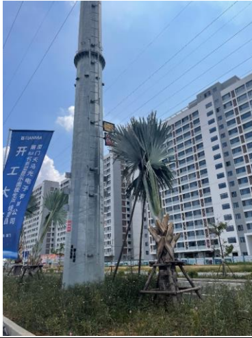
16#塔基植被恢复
