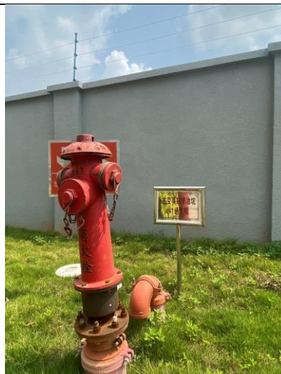
主变事故排油坑
