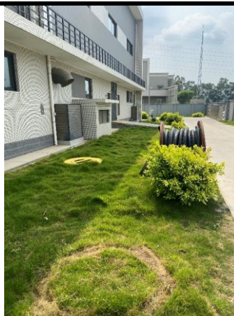
站内路面硬化及绿化
