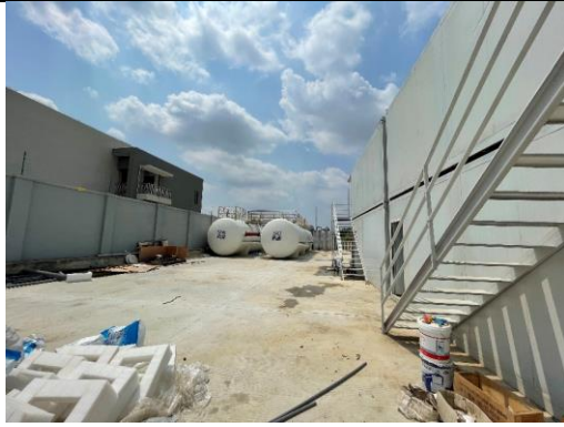
项目北侧（污水处理站）
