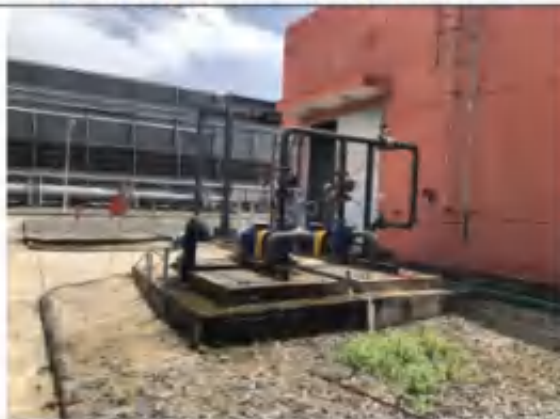
中江循环水场污水提升池
