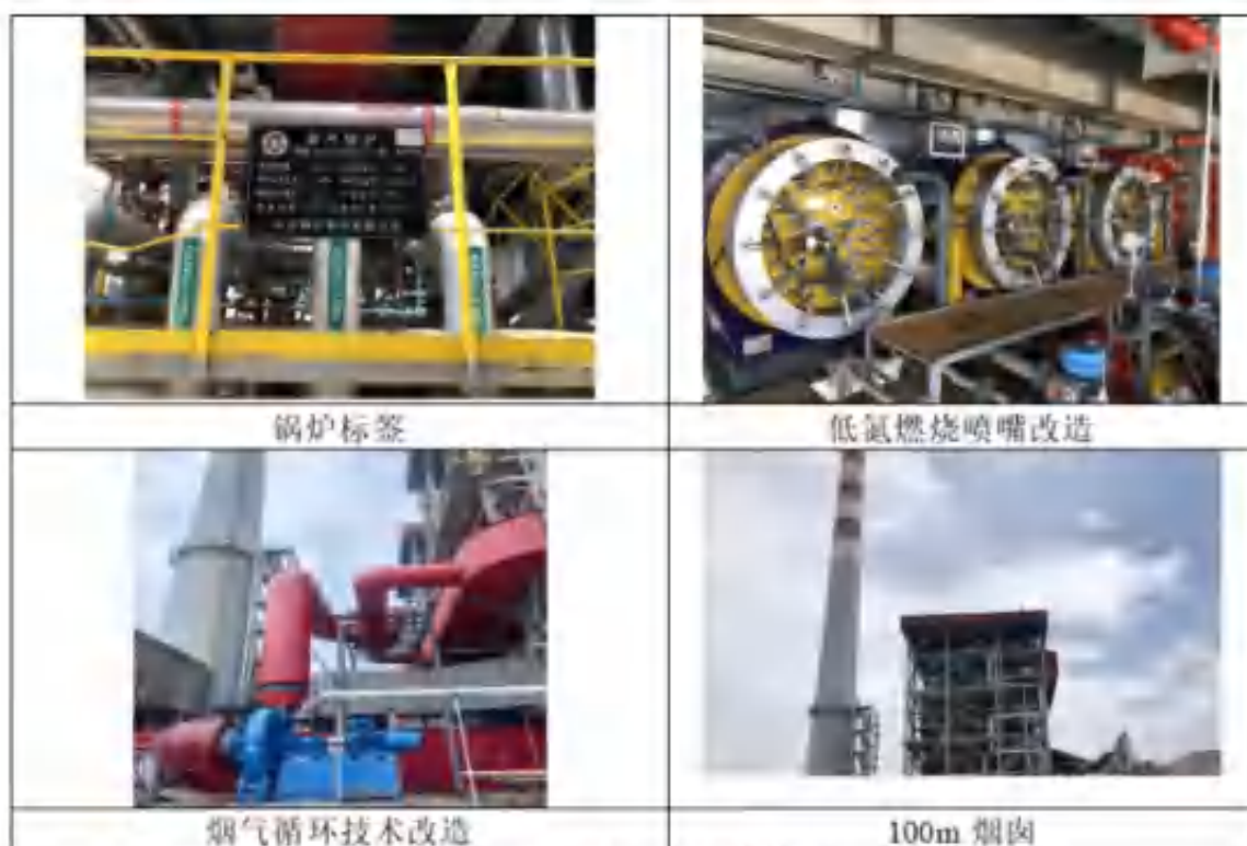
图 4.1-1 废气环保设施图
