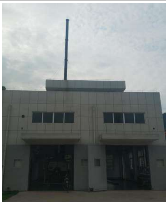
锅炉废气排气筒
