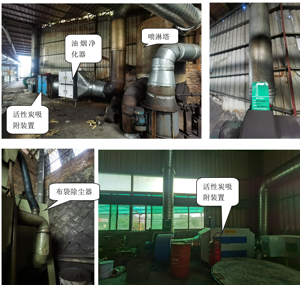
图1 废气处理设施图
