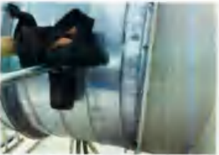
抛光废气处理设施◎P1 进口
