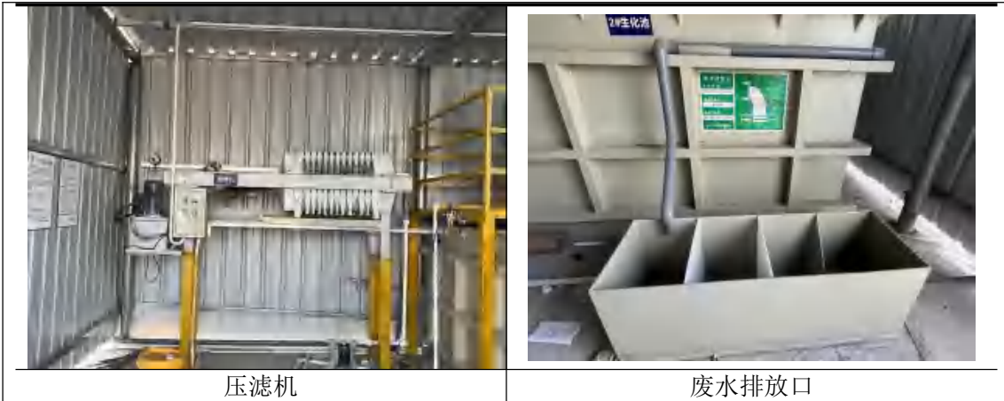
图3.2-3 相关废水处理设施照片
