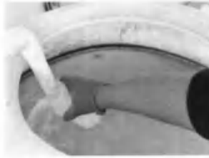
生产废水处理设施★W01 进口
