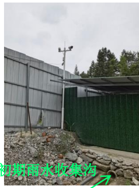
监控设备(可监控四级沉淀池、临时废石场)
