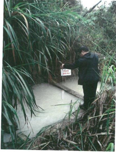
污水处理设施进口 W1
