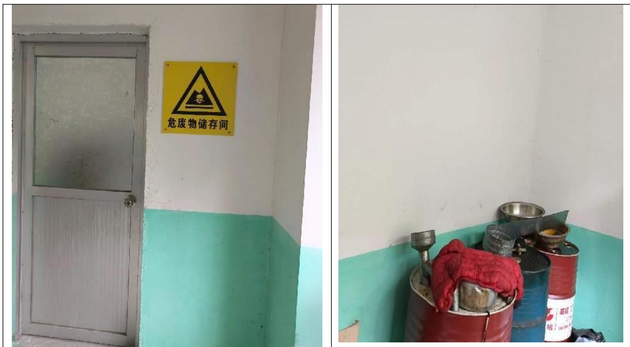
图4-3 危废暂存间照片
