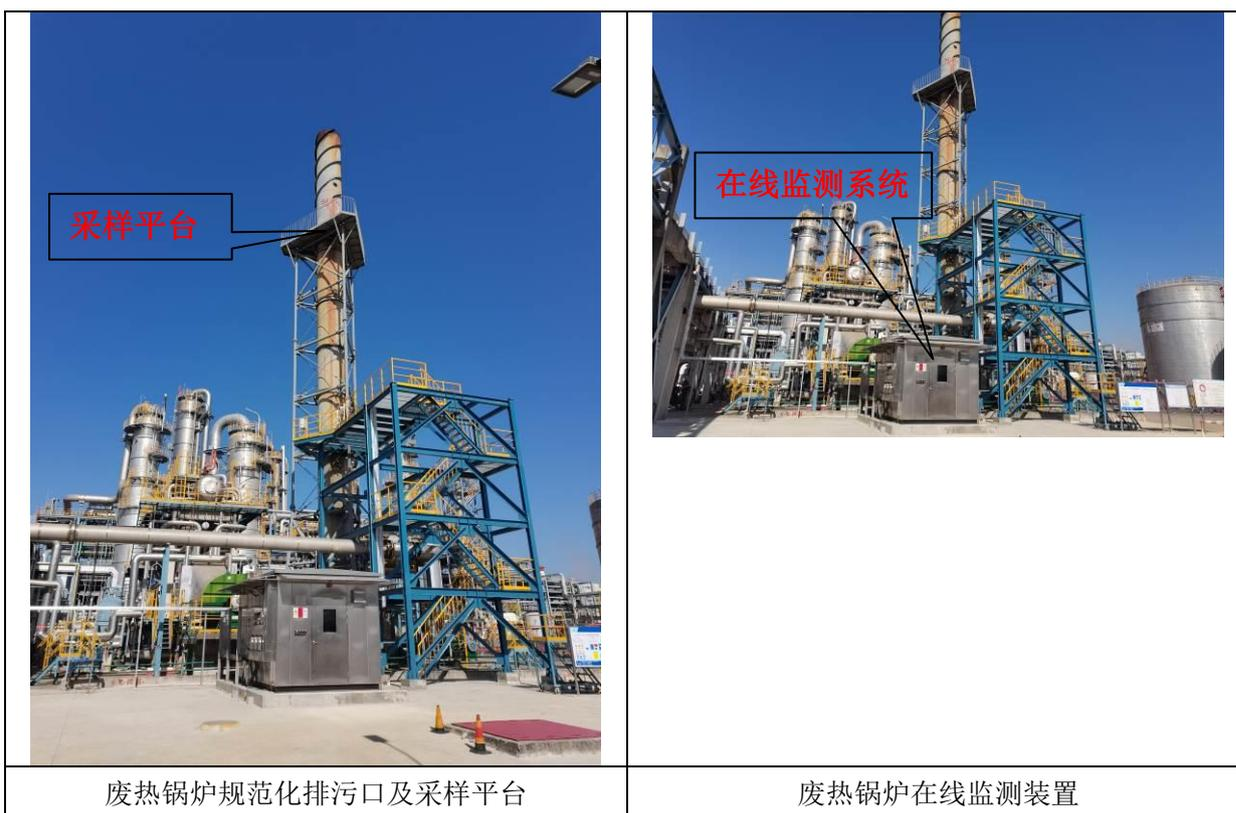
图 4.2.3 废热锅炉规范化排放口及在线监测设施
