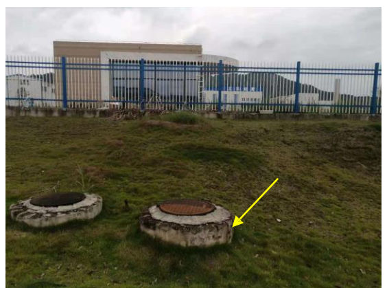
生活污水排放口
