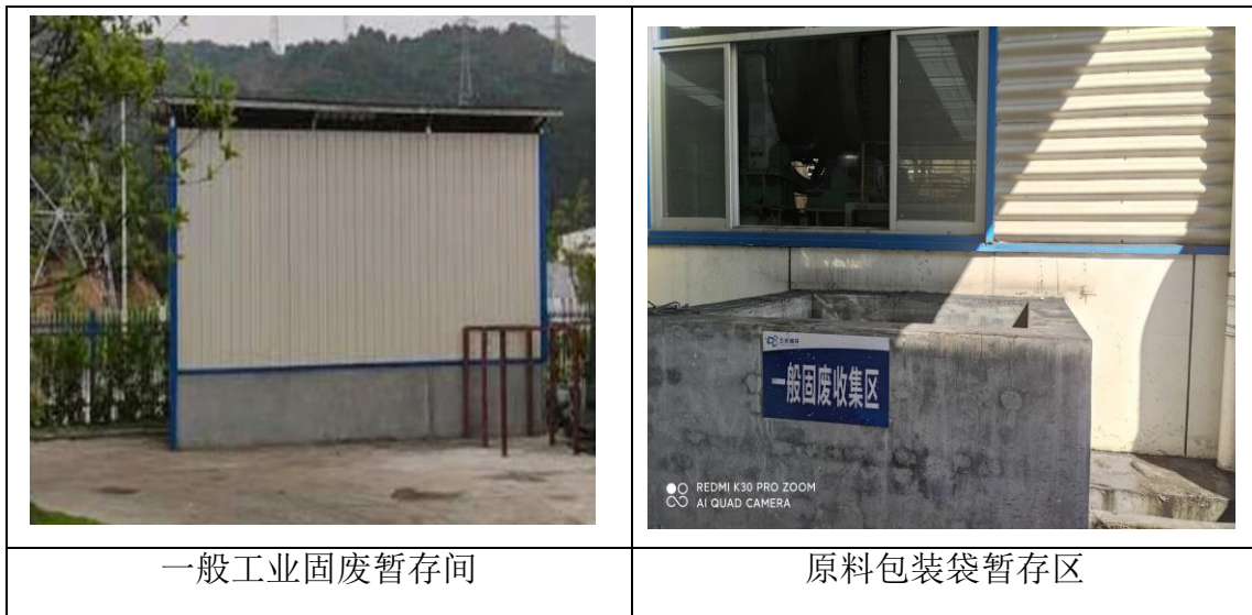
图 3.3-10 一般工业固废暂存设施现场情况
