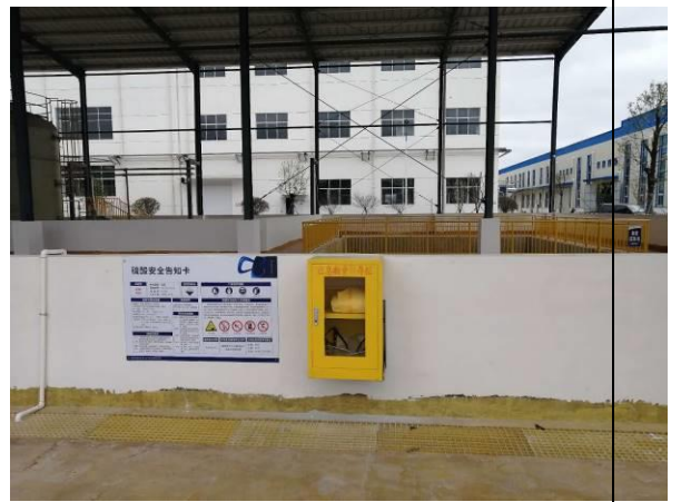
罐区防护物资贮存柜
