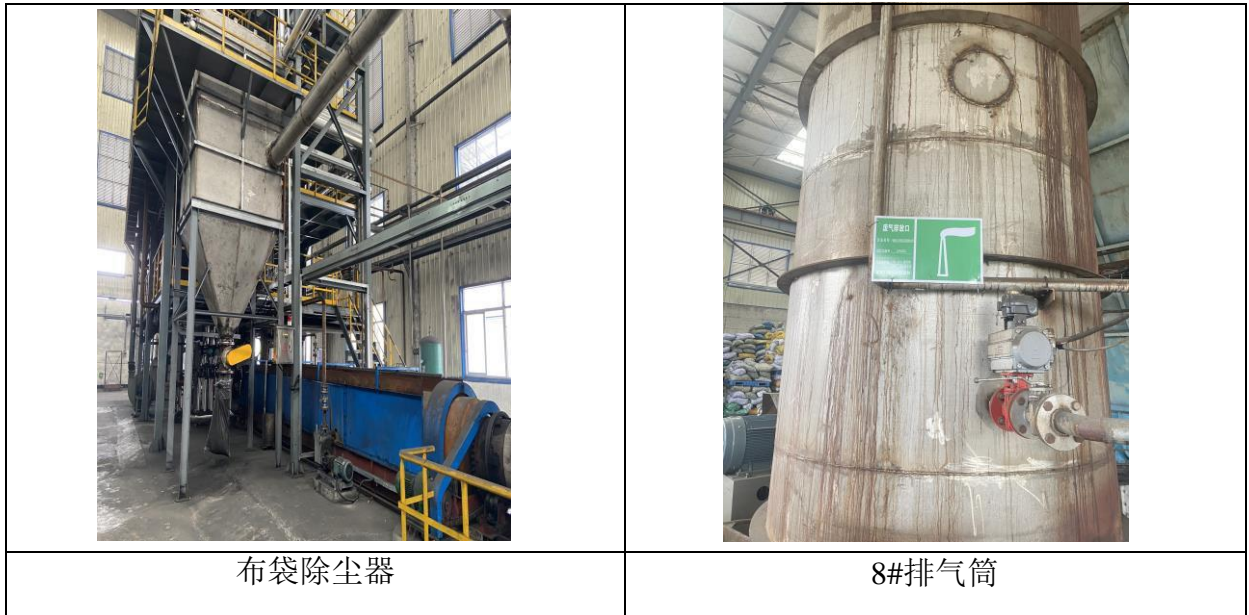
图 3.3-8 生物质炭废气治理设施现场情况
