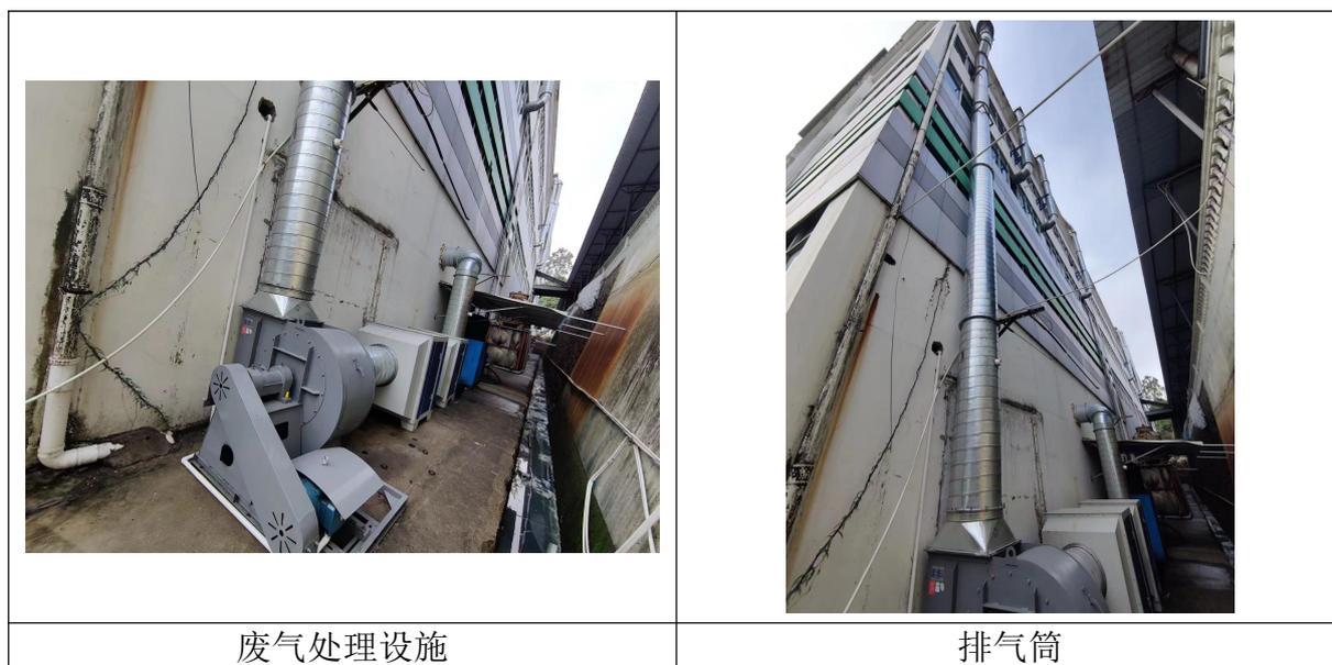
图 4-3 项目废气处理设施图
