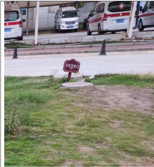
污水站污水出水口
