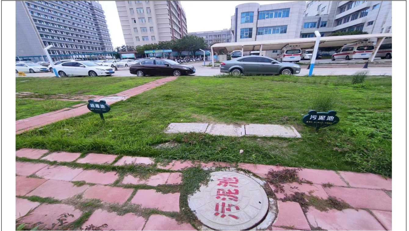
消毒池以及污泥池
