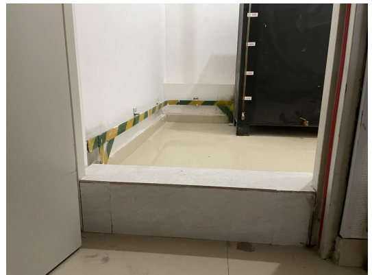
柴油罐区围堰
