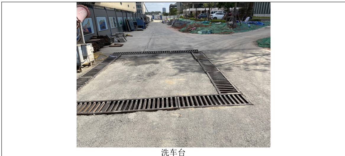
图 4-1 运输车辆设置的清洗设施情况现场图
