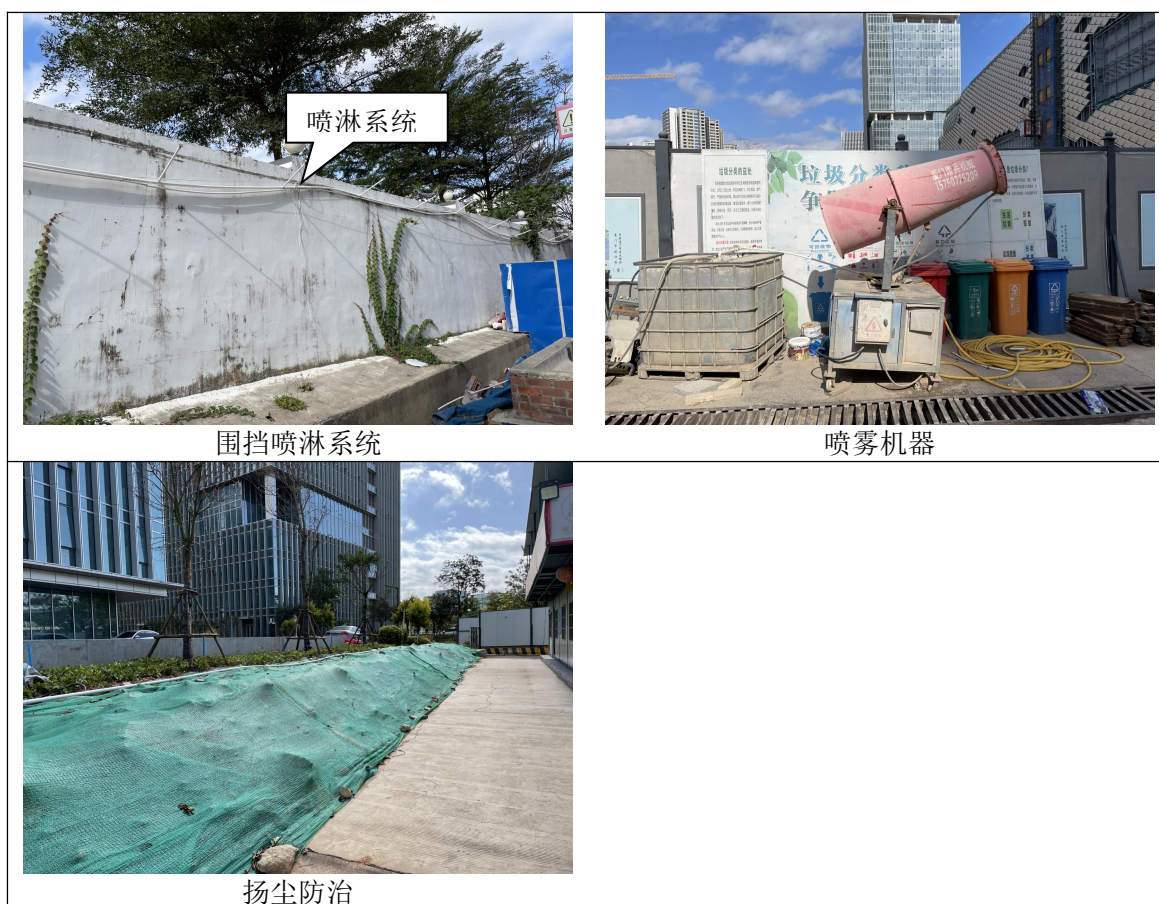
图 4-3 施工期扬尘治理措施局部图
