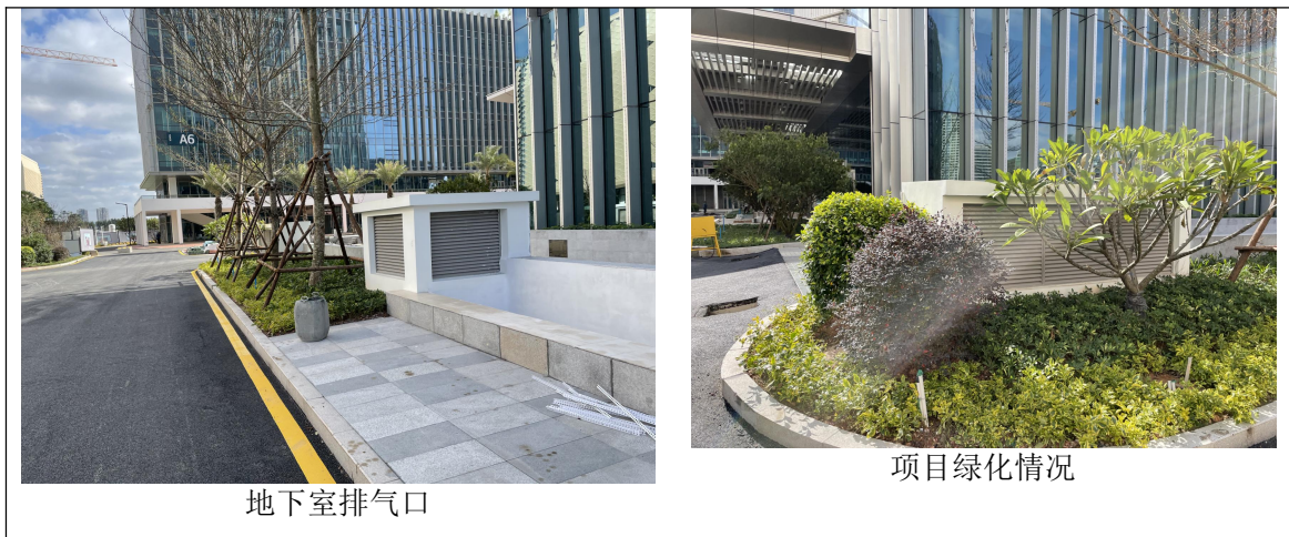
图 4-4 废气设施设置情况现场图
