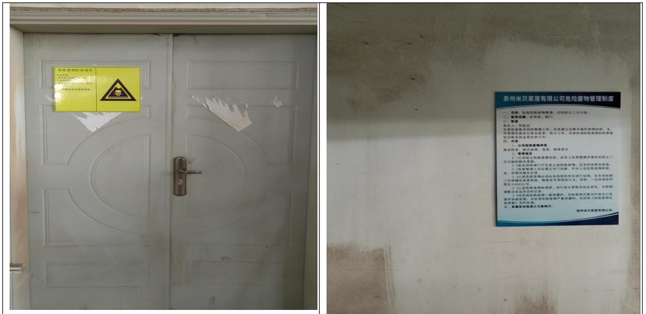
图 3-2 危险废物暂存间现状图
