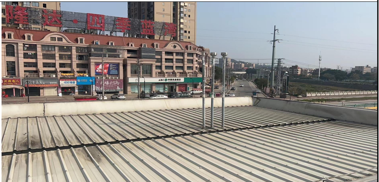
油罐油气排放装置
