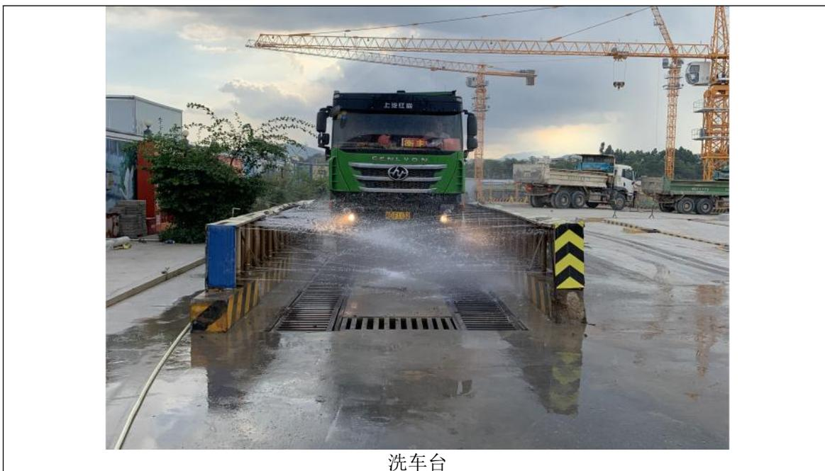
图 4-1 运输车辆设置的清洗设施情况现场图
