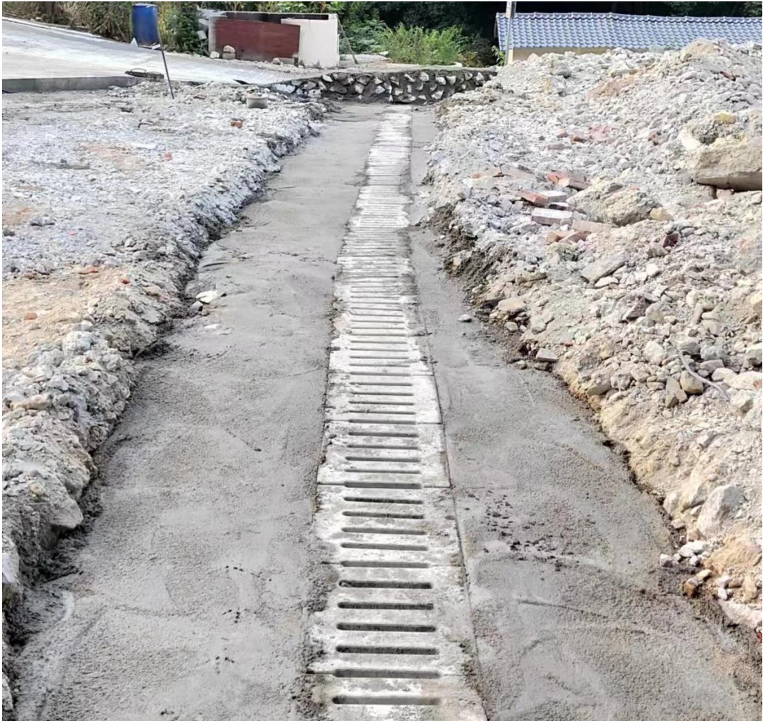
图 2.2-7 废石堆场淋溶水导排沟
