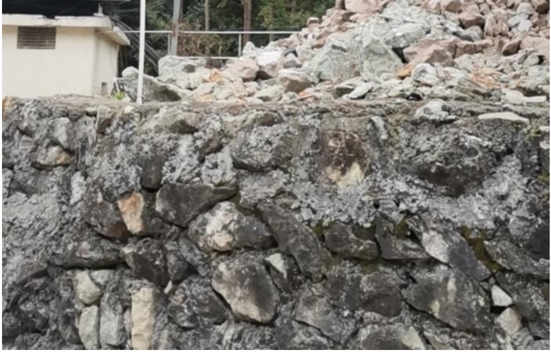
图 2.2-6 废石堆场拦渣坝
