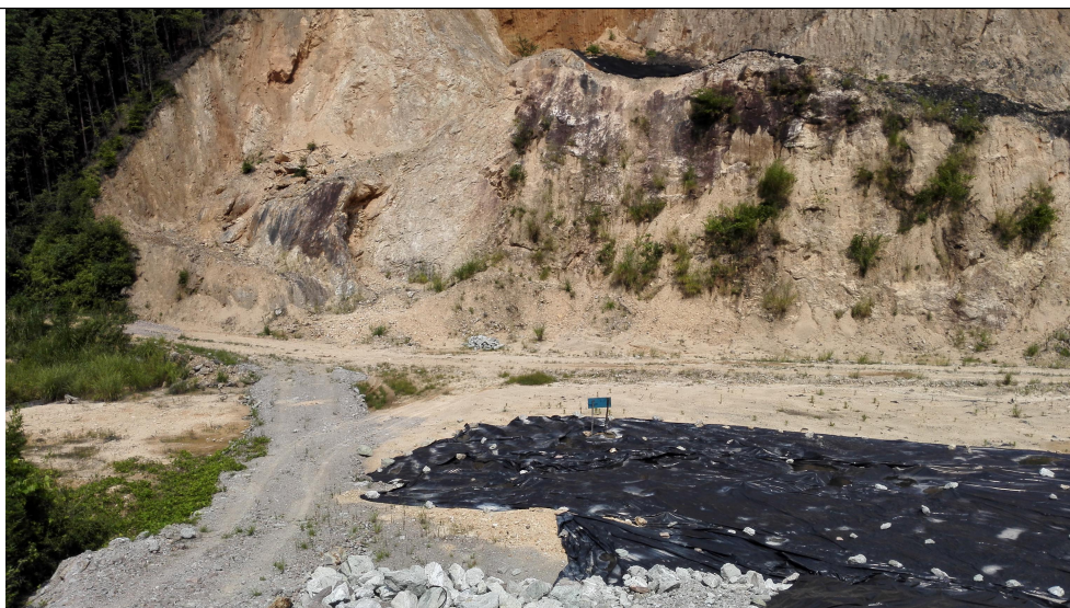
环评中早期塌陷区
