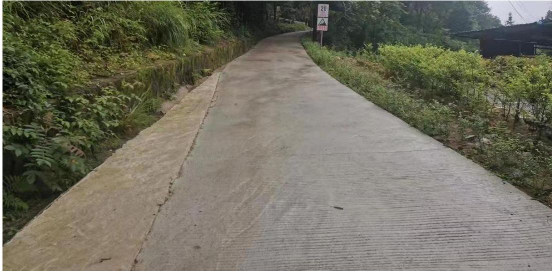
图 2.2-4 厂区道路现状
